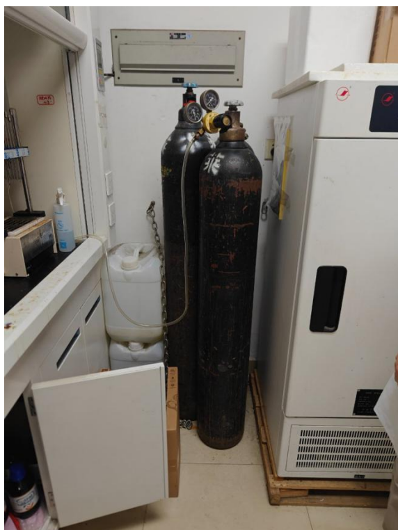
7. 园艺 79-315 气瓶无固定无状态牌
